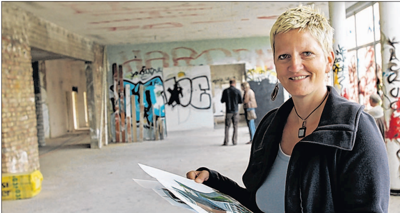
Anett Lachnit vom Behinderten- und Rehasportverband schaut sich schon mal ihre künftigen Büroräume im entkernten Anbau des Sportforums an.
