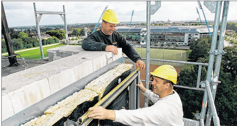
Marco Formella (r.) und Thomas Biedenweg von der Metallbau Rostock GmbH sind gerade hoch oben dabei, die Fassaden des Sportforums zu dämmen und mit Aluminium-Platten zu verkleiden.
